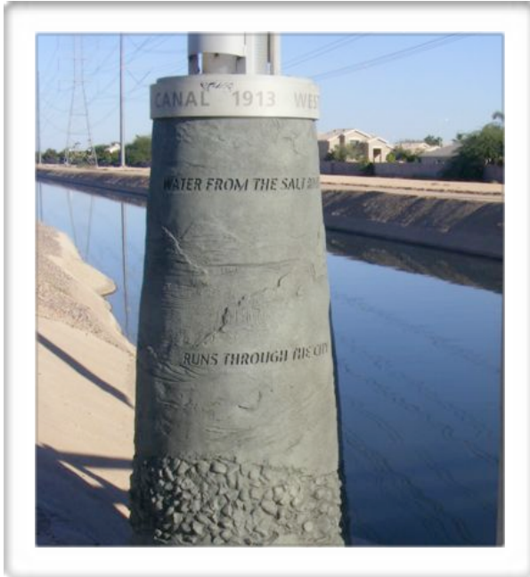
Poste de un canal con bajo relieve
